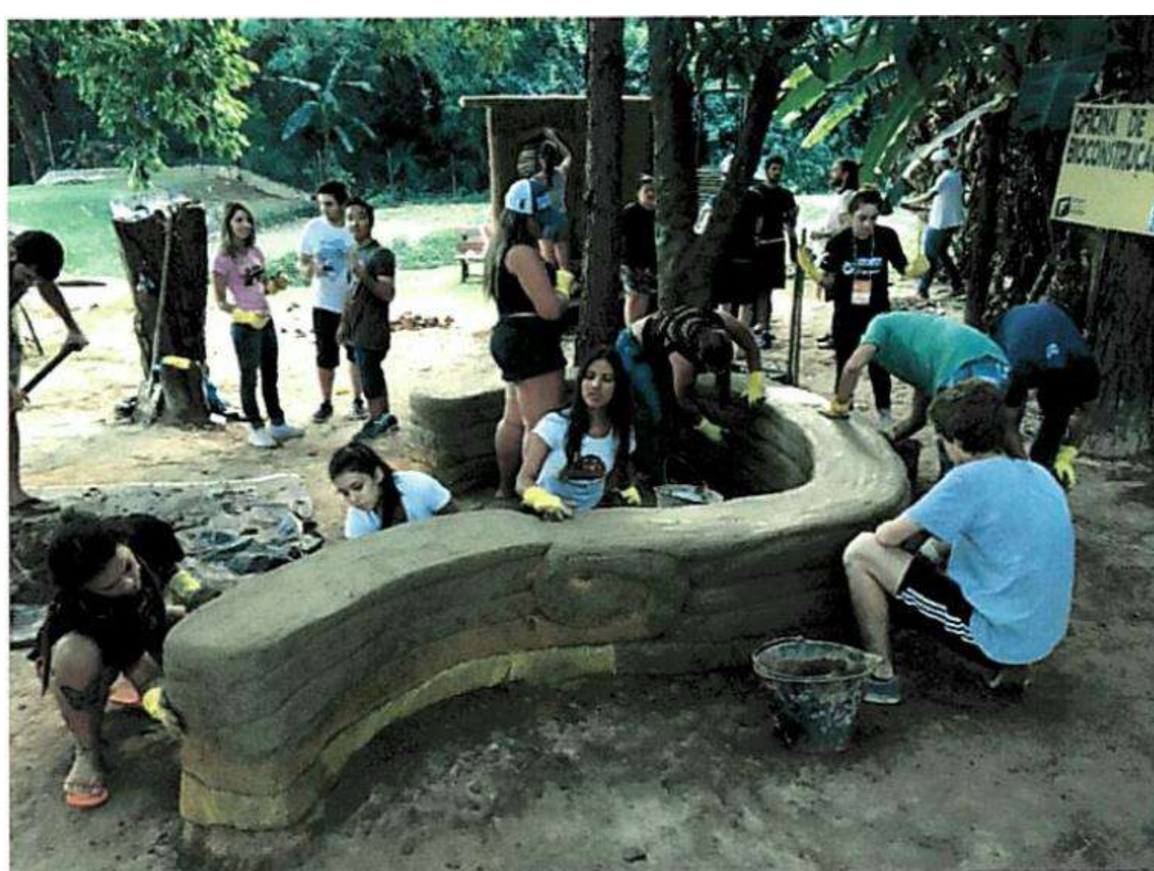
Figura 1 – Execução do banco de Hiperadobe.
