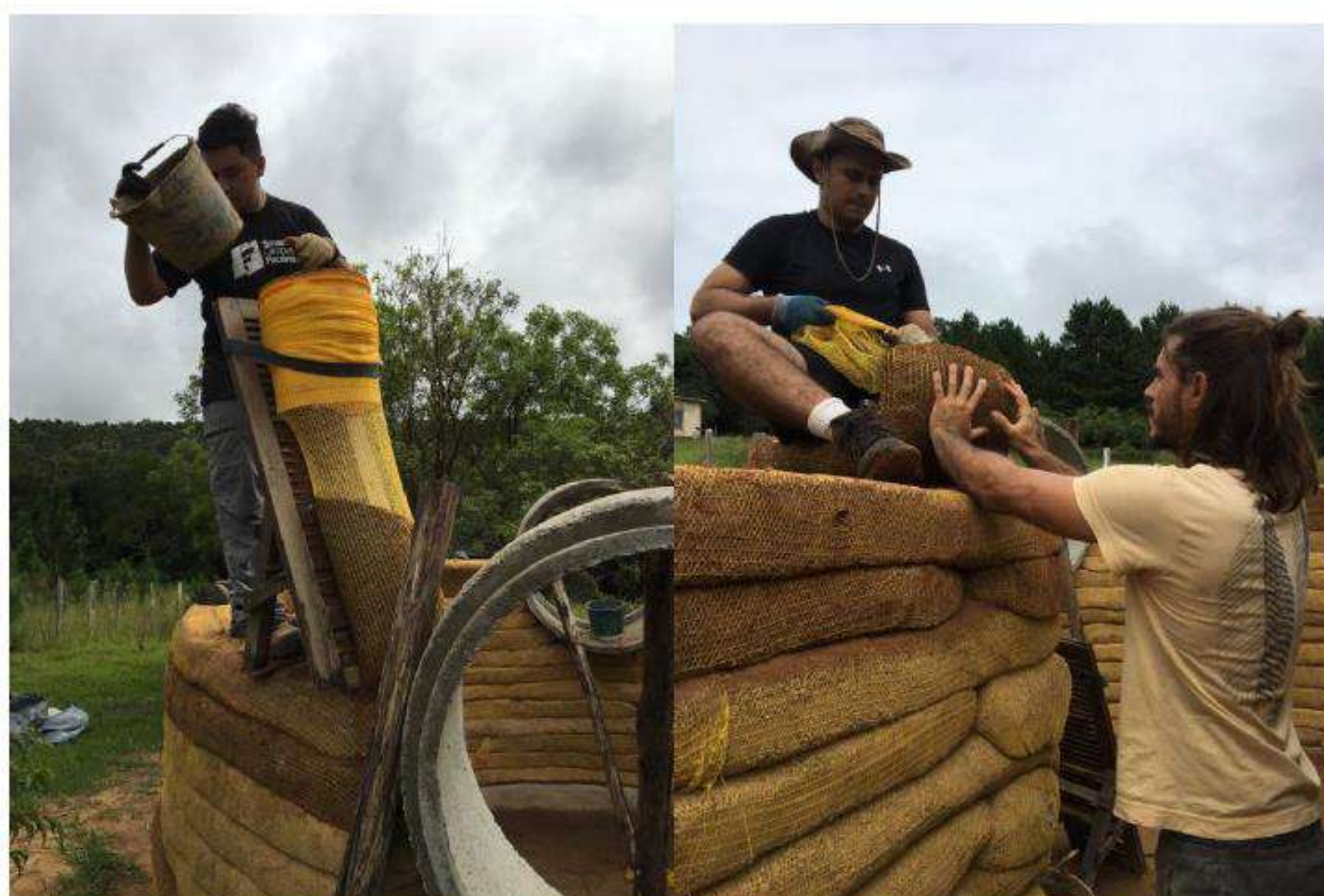
Figura 1 – Execução de parede de Hiperadobe.
